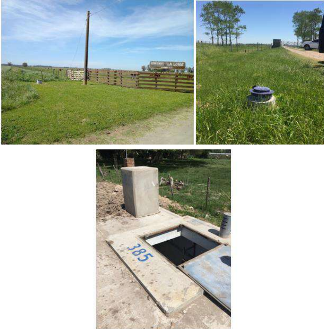
Figura 3. 91: Piezómetros con sensores- sin registro de nivel. 10562 -10520 – 385/Q10
