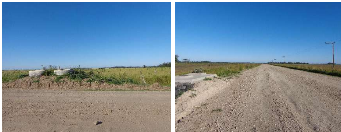
Figura 3. 8: Sistema Acueducto Oeste en el camino de acceso a Colonia Barragán
